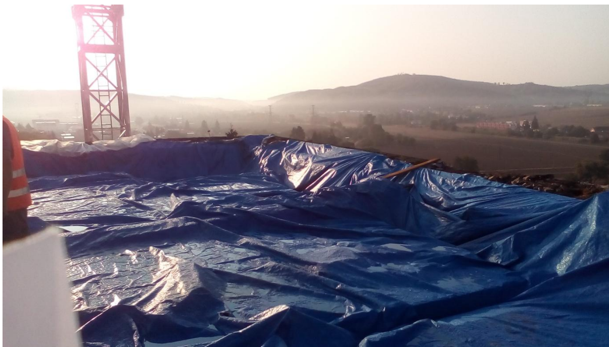
Fotografie z 31.8.2018 o provedení opatření proti zatečení
