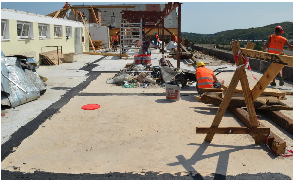
Demontáže ocelových konstrukcí, hydroizolační nátěry, fotografie 10.8.2018
