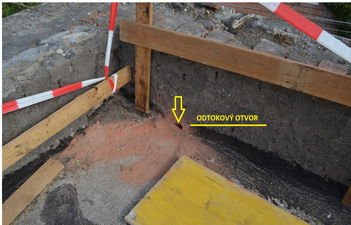
Příklad odtokového otvoru, 10.8.2018
